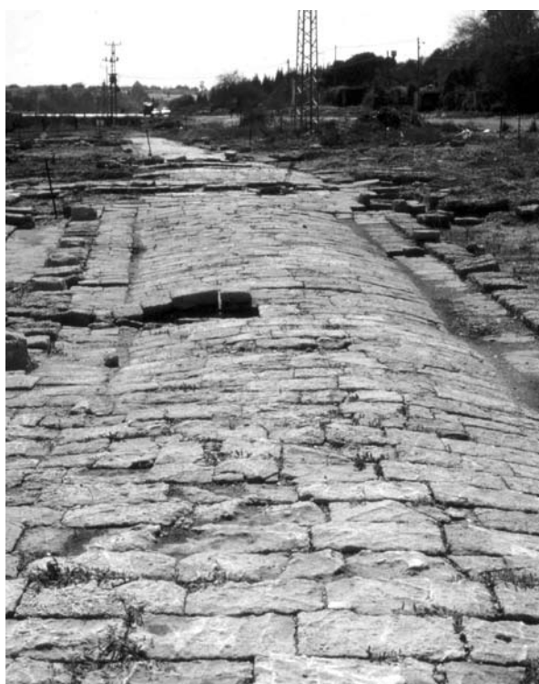
איור 14ב. הכביש הרומי ליד שוני, מבט דרומה. שימו לב לקמרון הכביש ולשוליים הבנויים (צילום: י' רול)
