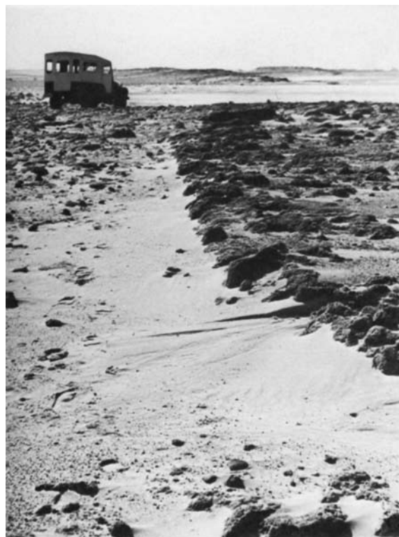
איור 39. כביש עכו-קיסריה, תוואי הדרך החצוב בכורכר (צילום: י' רול)
